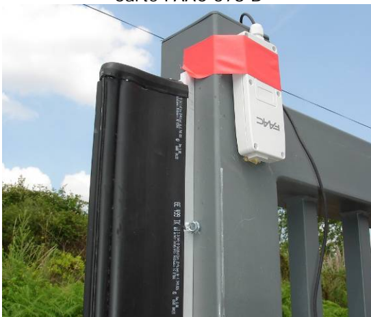
Palpeur ASO GE 499 TK et transmetteur radio FAAC
